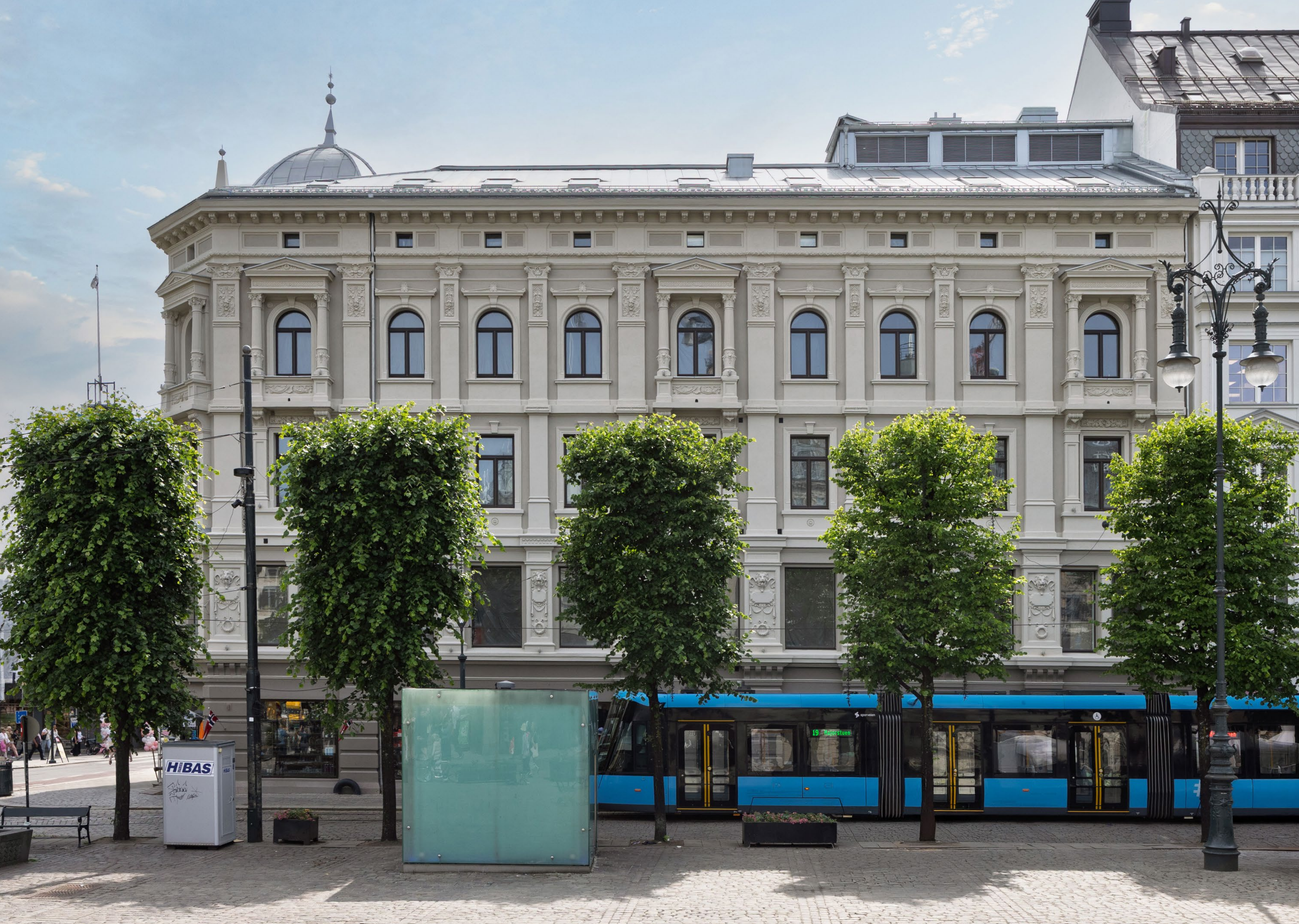
Fasade mot Stortorvet
