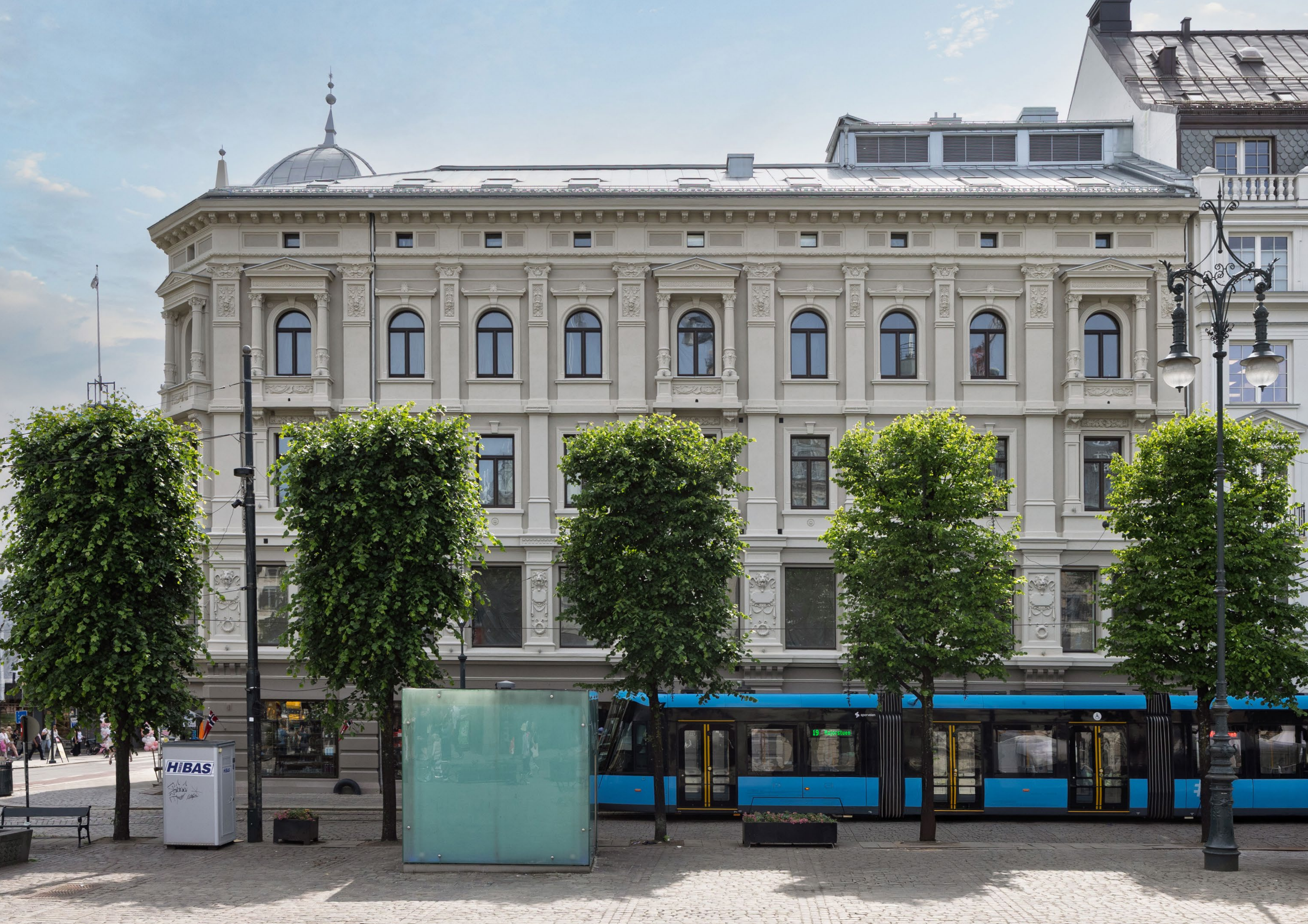
Fasade mot Stortorvet
