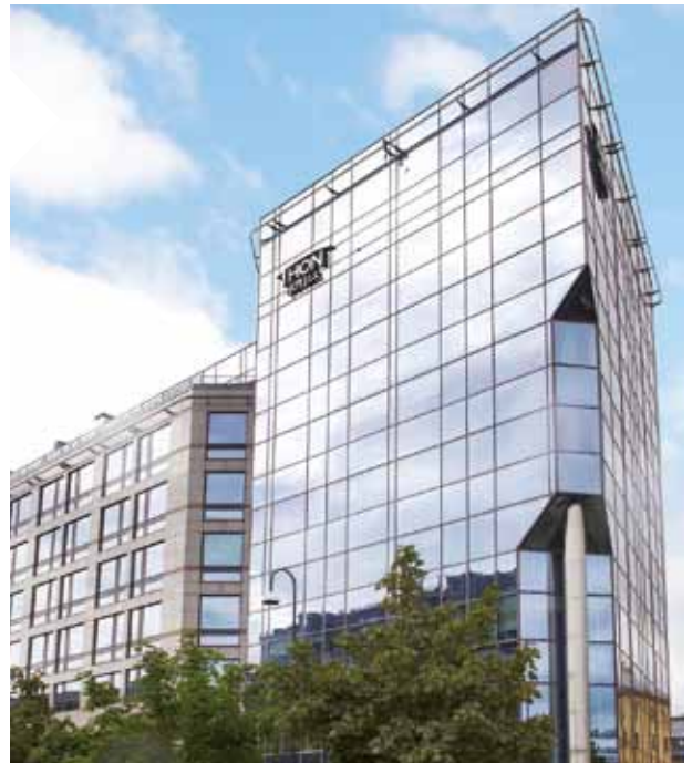
Munkedamsveien 45 (Vika Atrium)
